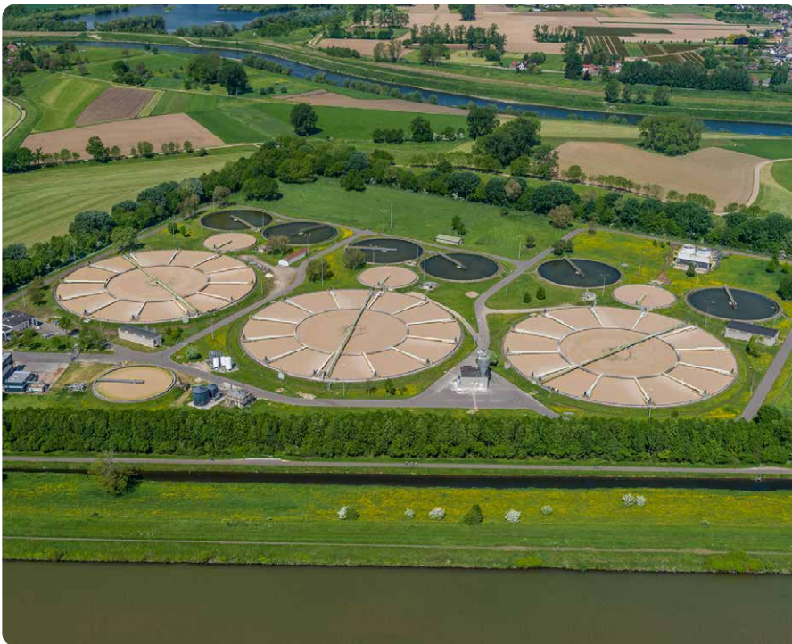
De Integrale Afvalwaterzuiveringsinstallatie, kortweg IAZI, van Circle Infra Partners.
