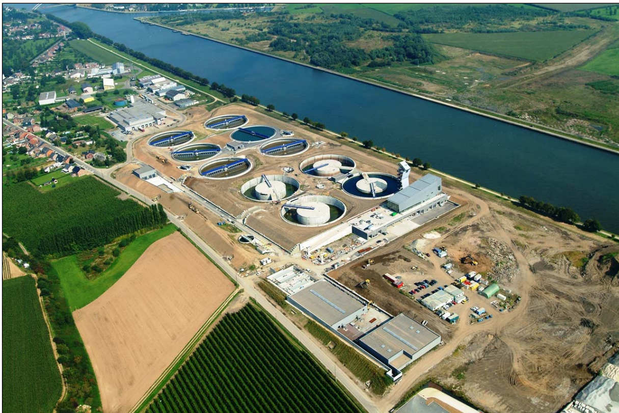
Foto 2: Rioolwaterzuiveringsinstallatie Oupeye in aanbouw (bron: AIDE).
