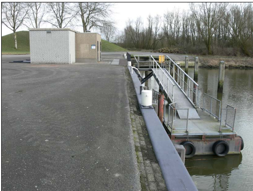
Figuur 33: Innamepunt Evides langs het Gat van de Kerksloot
