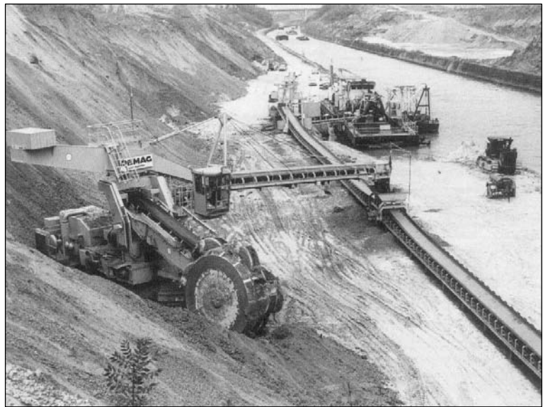
Figuur 4: Het graven van het Albertkanaal in het diepste punt bij Vroenhoven (foto: Grensschap Albertkanaal)
