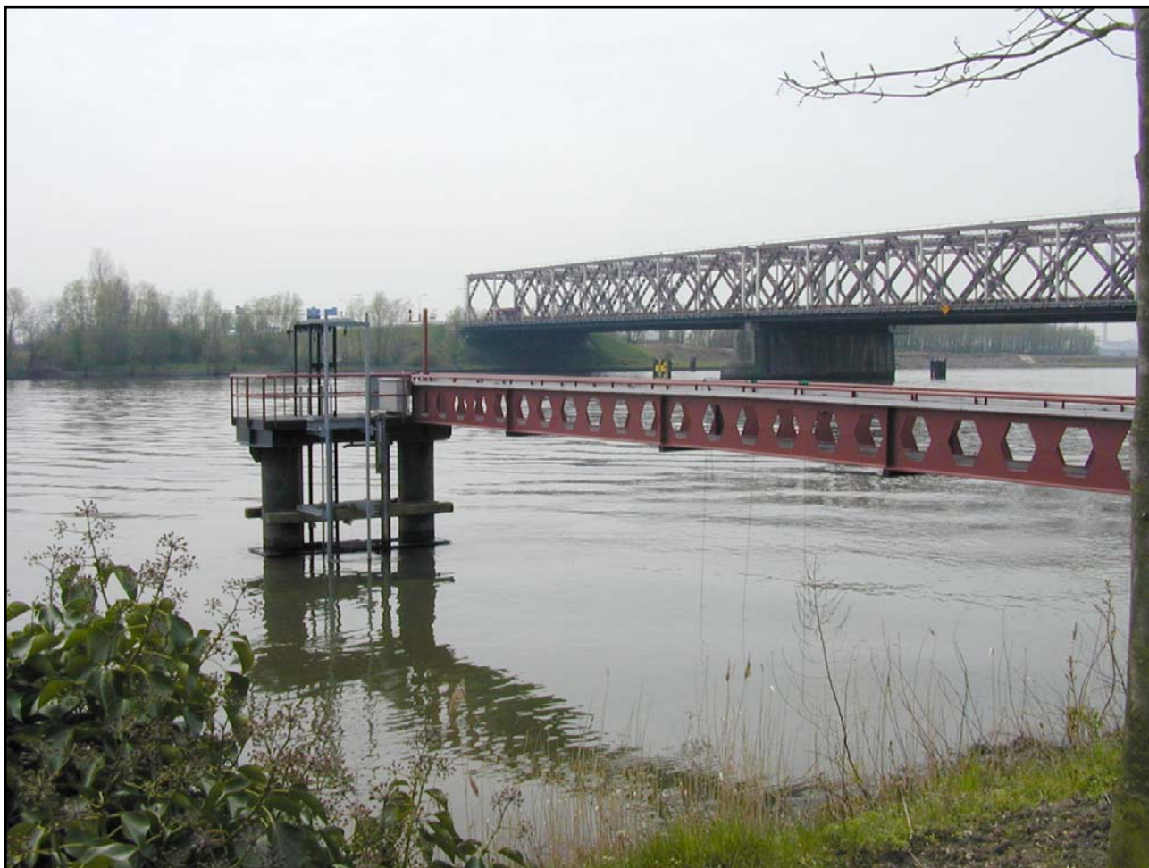
Figuur 1: De inname uit de Bergsche Maas voor het meetpunt Keizersveer, representatief voor de inlaat uit Gat van de Kerksloot (foto: WBB).
